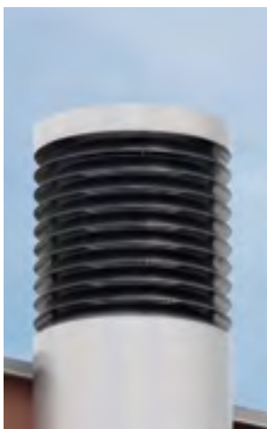
Beispiel Lamellenturm, gerades Dach mit bündigen Lamellen
